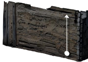
Bewegen Sie die Sonde in gleichmäßiger Geschwindigkeit nach oben und folgen Sie einer imaginären Linie bis zum Ende des Messfeldes.
