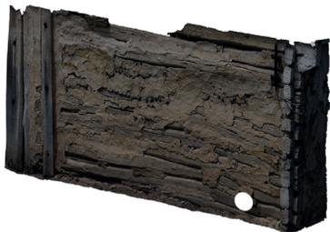
Richten Sie die Sonde auf den Startpunkt der ersten Messbahn (unten rechts im Messfeld).
